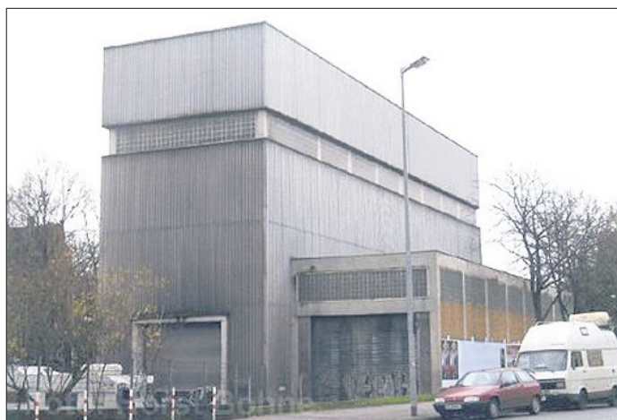
Der Gleisanschluss zum Küchengarten (Foto oben: Michael Jürging) – im Bild die Brücke Nieschlagstraße – ist bis auf Weiteres außer Betrieb. Der Kohleumschlagbunker an der Fössestraße (Foto: Horst Bohne).
