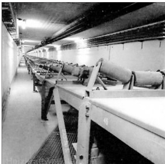
Der Bekohlungstunnel, auch Bekohlungskanal genannt, im Jahre 1960 vor dem Einbau der Förderbänder Quelle: Heizkraftwerk Linden
