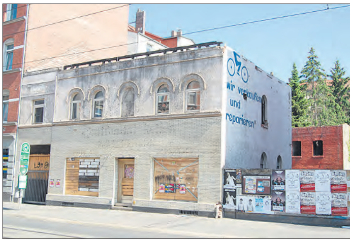
Der derzeitige Zustand des Hauses Limmerstraße 98. Foto: Mallast
