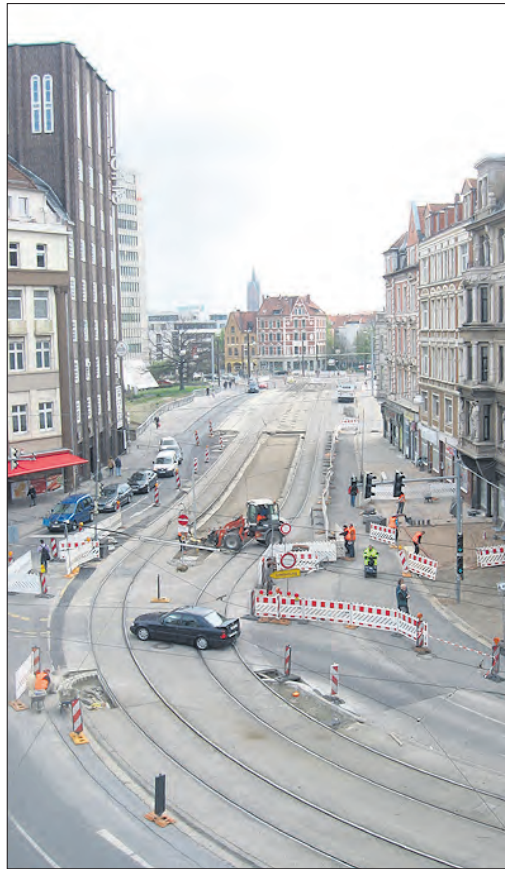
Soll zum Jahreswechsel 2012/13 endlich wieder vollständig für den Verkehr freigegeben werden: die Benno-Ohnesorg-Brücke. Foto: Wiesemann
