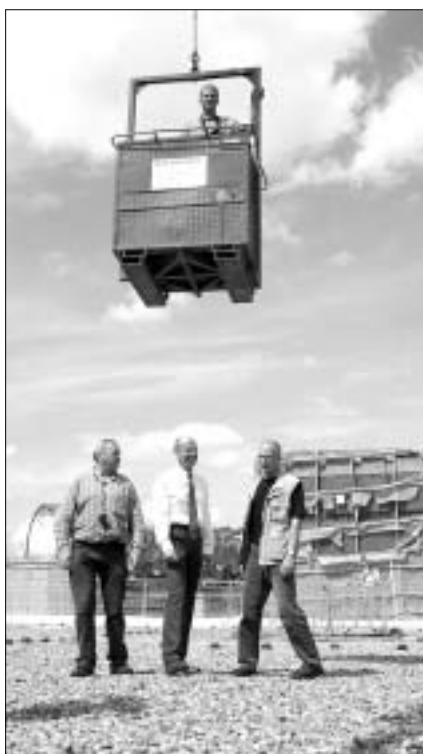
Bei der Arbeit: Manfred Wassmann, Gisbert Fuchs und Michael Jürging (von links) auf dem Dach des Wasserhochbehälters. Im Korb des Autokrans: Fotograf Uwe Schmida. Foto: Bachmann
