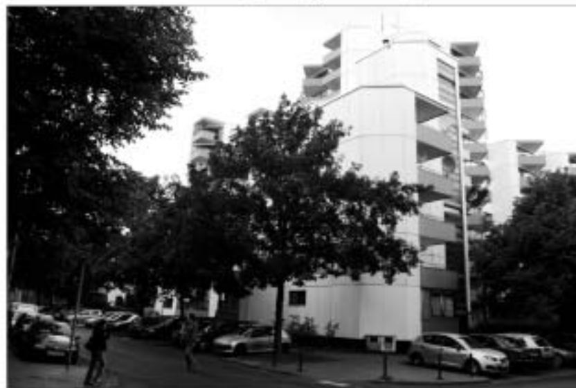
Wohnblock an der Mathildenstraße nach der Sanierung
