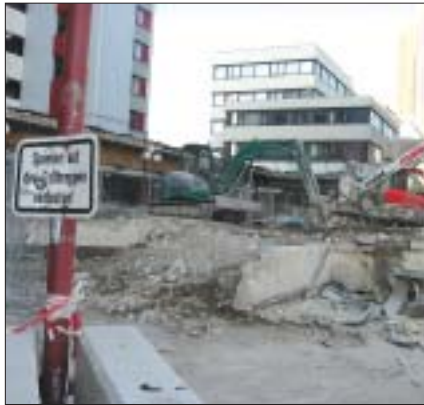
Baustelle ohne Bauarbeiter? Die Arbeiten am „Linden-Park“ gehen derzeit eher zögerlich voran. Foto: Wiesemann
