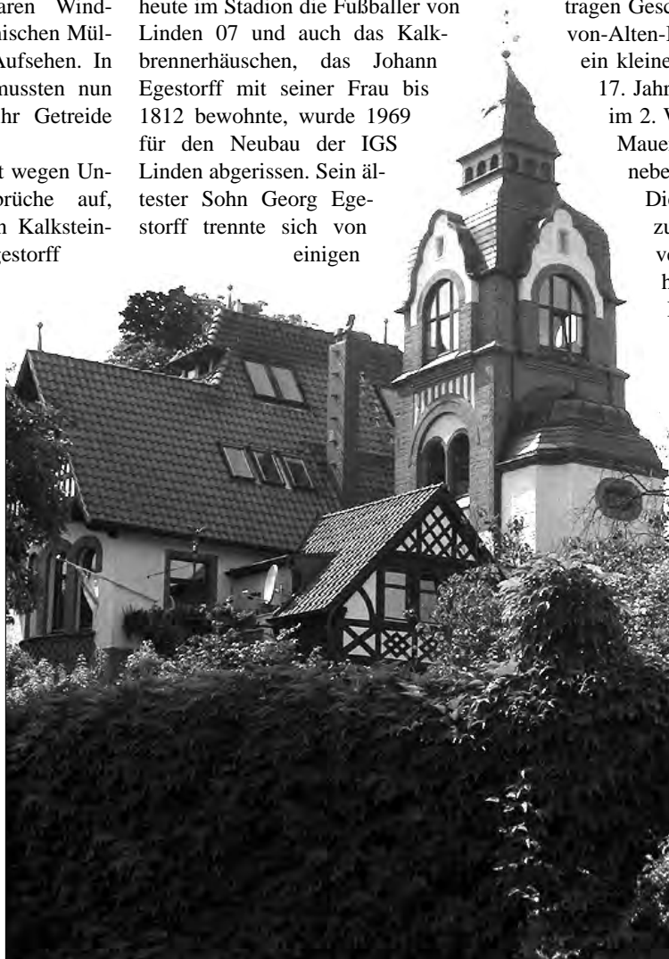
Imposant: die zu Beginn des 20. Jahrhunderts für den Mittelschuldirektor Hinrich Osmers errichtete „Villa Osmers“.
